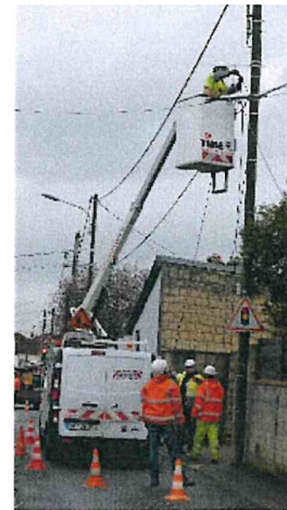
Pose d'un câble de fibre optique sur une infrastructure aérienne
